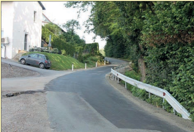
Sanierung Dorneggerstraße im Juni 2021
