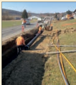
Verlegung des Glasfaserkabels bei der Geh- und Radwegbaustelle von St. Marein in Richtung Studenzen
