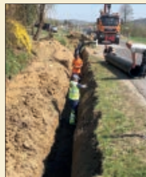
Verlegung des Glasfaserkabels bei der Geh- und Radwegbaustelle von St. Marein in Richtung Studenzen
