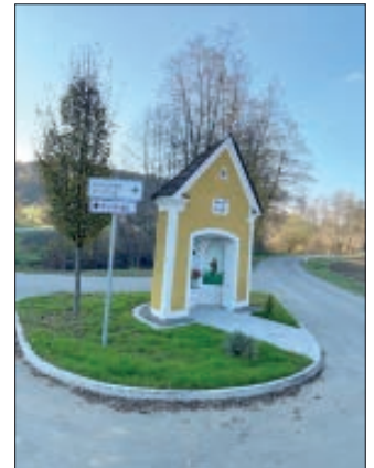
Fertigstellung Platzsanierung Bergerkapelle
