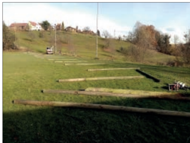
Erneuerung des Zaunmastens
