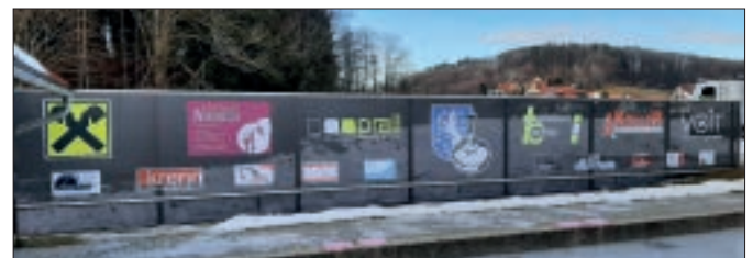
Neues Windschutznetz bei der Eisanlage
