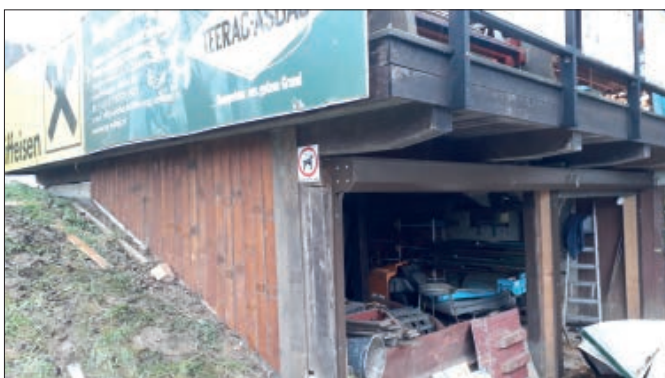
Der neue Seitenverschlag bei der Garage
