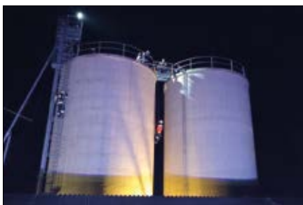
Abschnittsatenschutzübung mit Abseilung vom Silo
